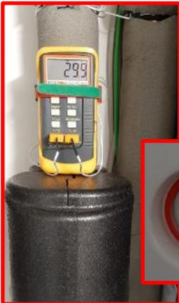
Analoge Temperatur-Anzeige bis 120 °C sinnlos bei WP mit nur 25°C bis 40°C Vorlauf
