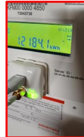
digitaler Stromzähler mit aufgesetztem „power-fox“ Lastgang Auslesung über SO-Schnittstelle und WLAN
