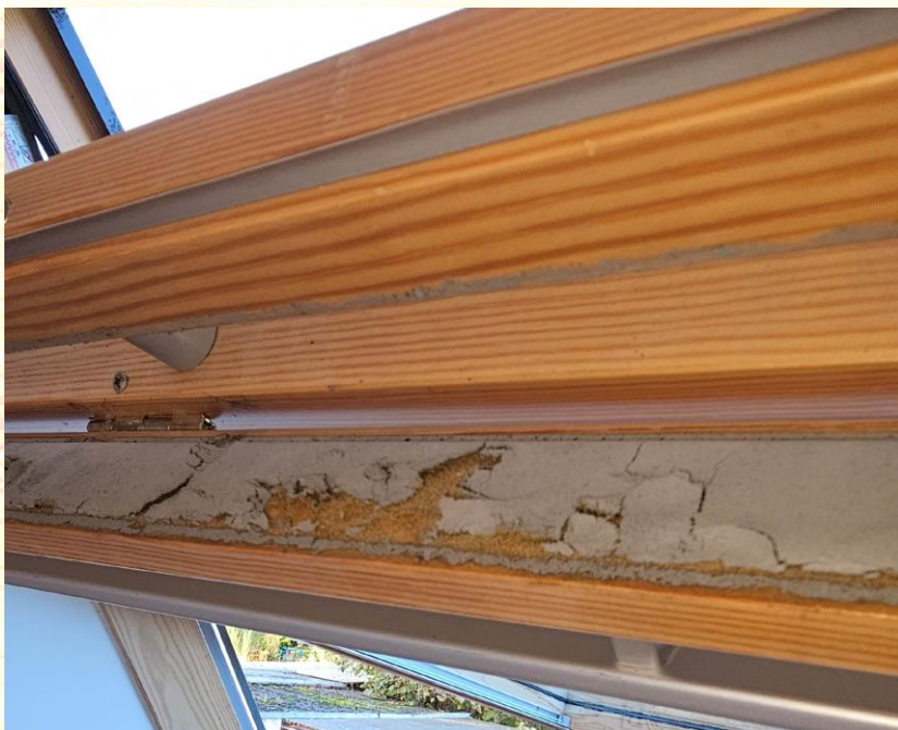
Defekte Klappendichtung
