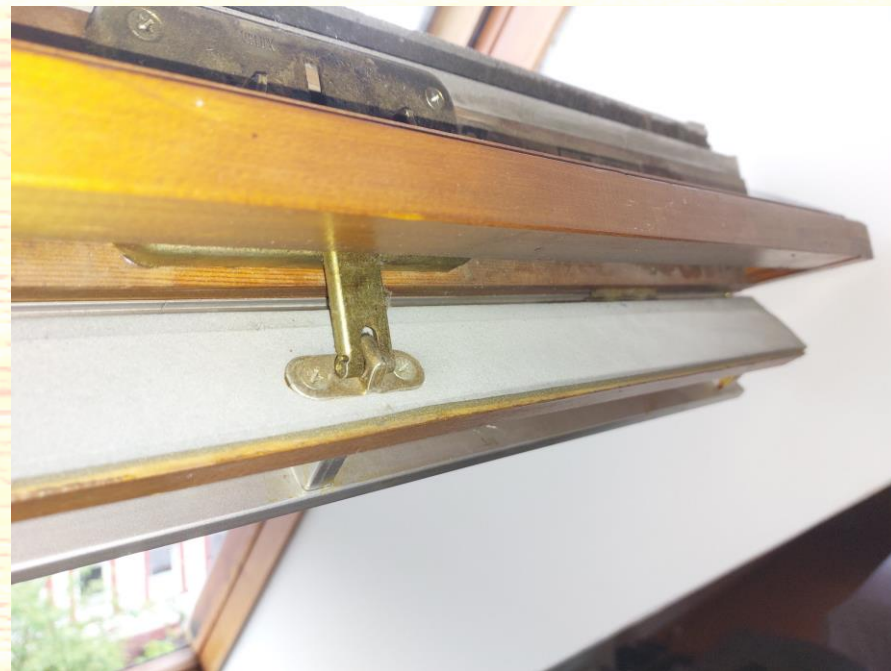
Sanierte Klappendichtung
